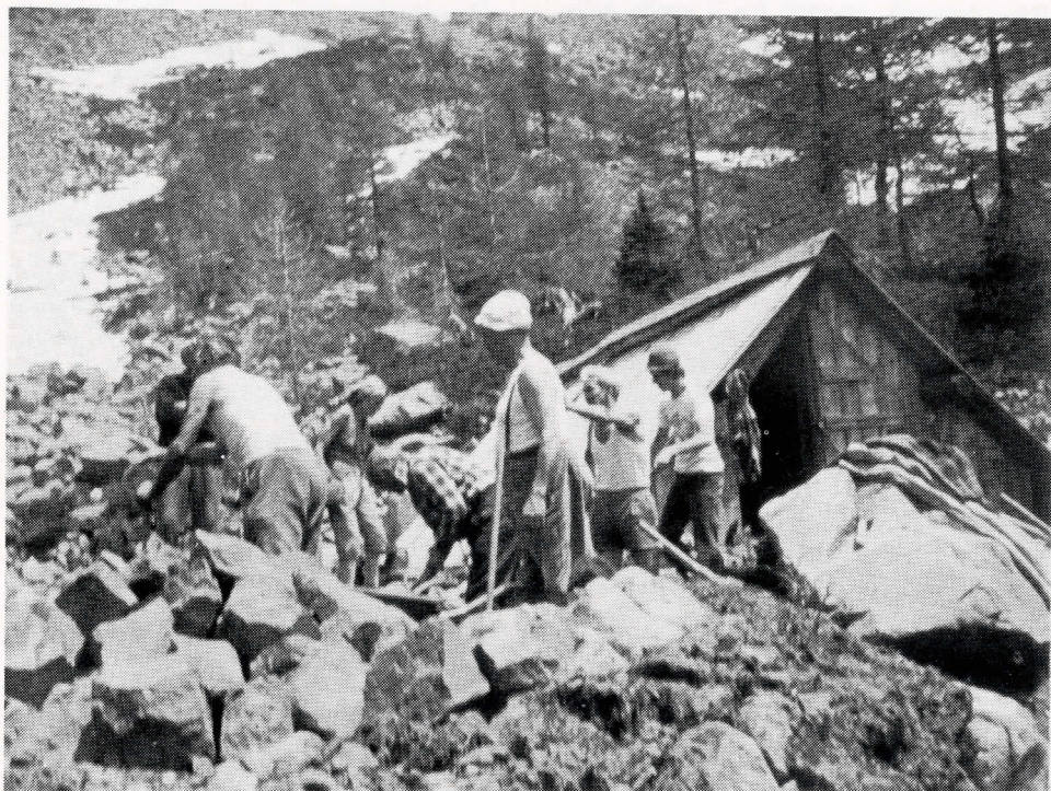
Lavoro di soci al costruendo rifugio del Laner.
